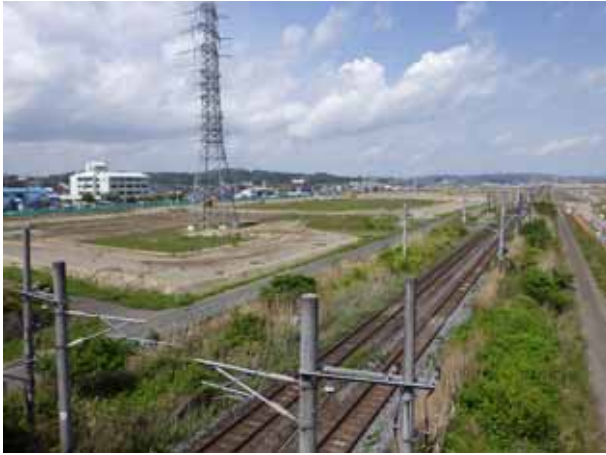
No.11 国道4号跨線橋（北方向）
