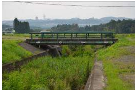
② 新館下橋
