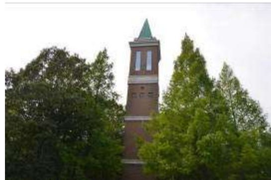
⑩ 寺岡高架水槽（とんがりタワー）
