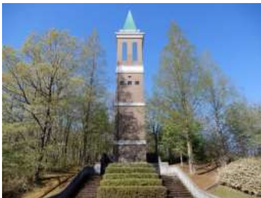
⑪ 寺岡高架水槽（とんがりタワー）
