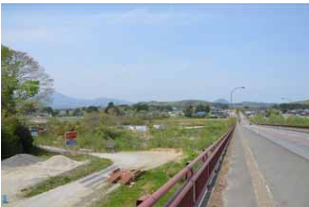
⑦対象事業計画地南東側(遠景)
