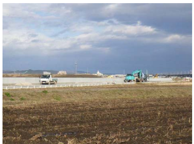
▲外周道路工事状況 (2021年12月21日)
