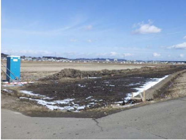
▲畦畔設置工事状況 (2018年2月19日)
