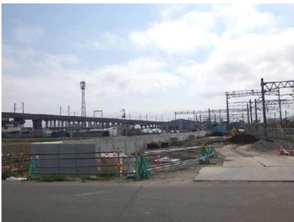
▲中引上げ線造成工事状況 (2022年4月20日)
