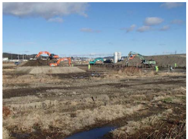
▲造成・地盤改良工事状況 (2022年12月27日)
