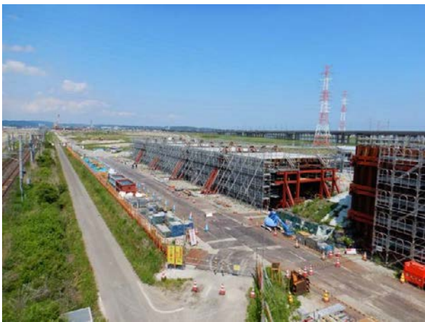
▲国道4号函渠工事状況 (2022年5月24日)
