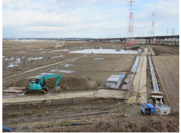
▲水路付替工事状況 (2020年1月30日)
