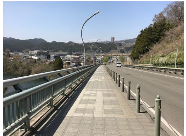
No. 5 供用時（秋季）現況写真
