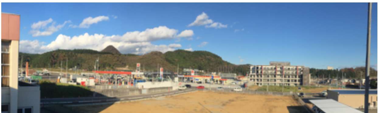
No. 9 現況写真 (供用時)
