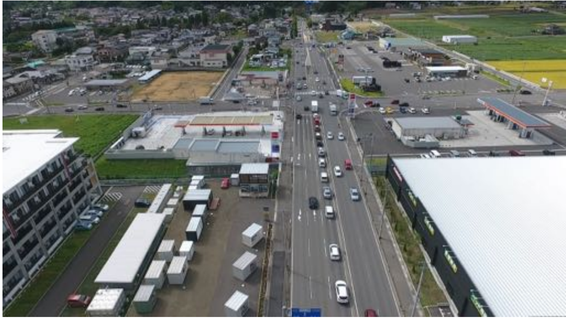
参考写真④ ドローンによる空撮 9 月（事業区域中央上空から西方を望む）
