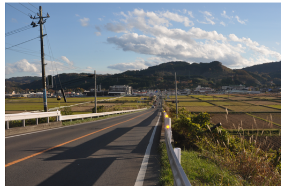
No. 6 供用時（秋季）現況写真
