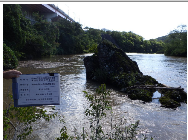
写真 7-1-6 名取川合流前(左岸より下流方向) 撮影日：平成 30 年 10 月 1 日
