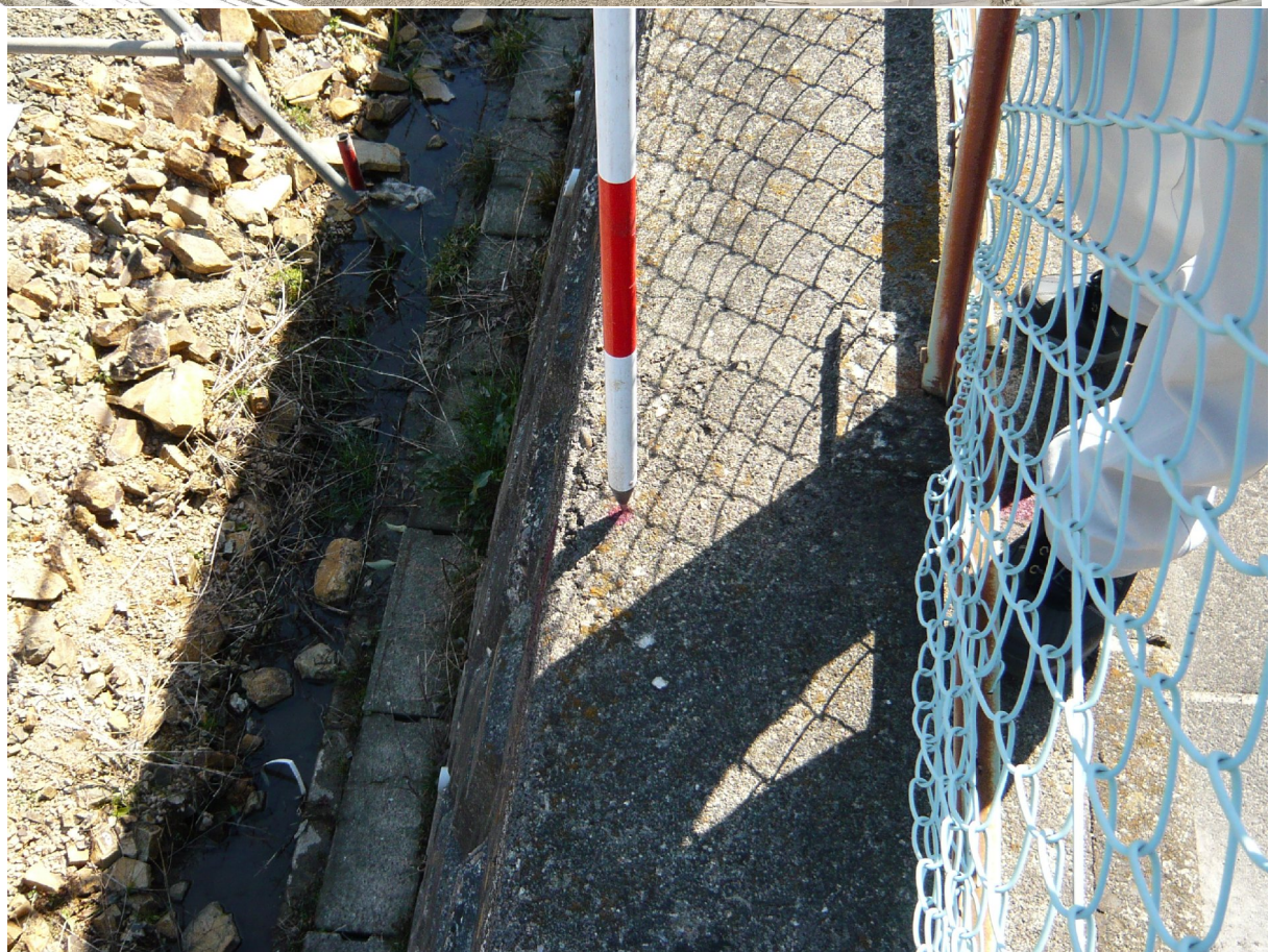
写真 7-2-1 調査地点（擁壁天端）
