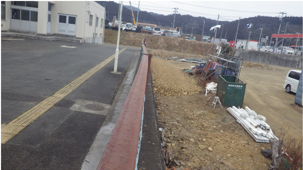
写真 7-2-2 調査地点（擁壁天端）
