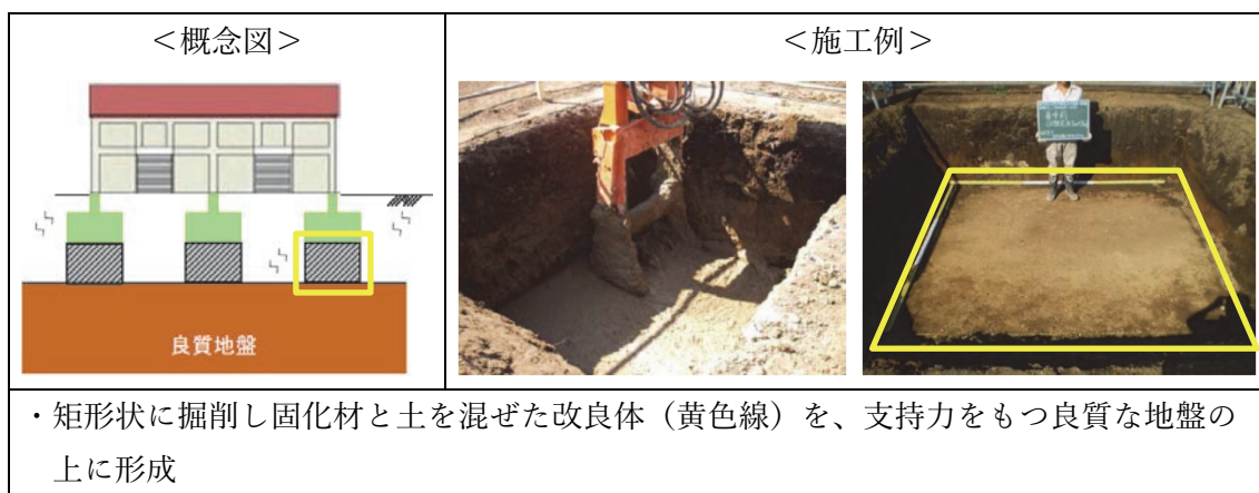
図 1.8-1 地盤改良工事のイメージ
