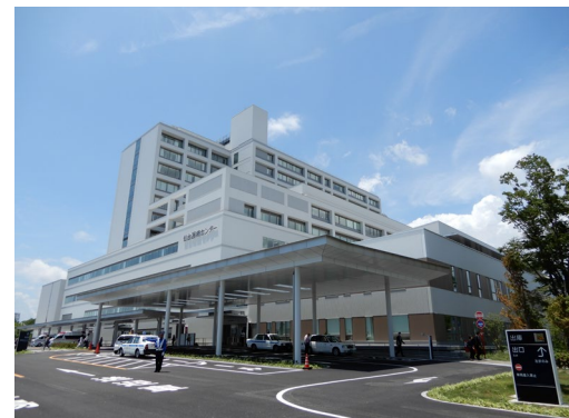
⑥ 病院本館・ロータリー
