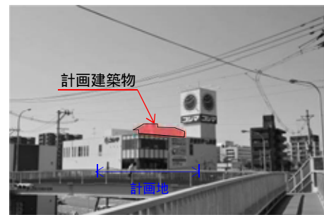
(建築物の視認状況)
