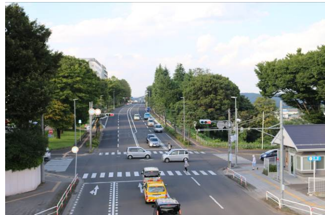
団地内中央の幹線道路（市道 東仙台泉(その2)線）
