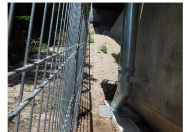
⑥左岸工事用地上流側面 排水路が施工完了し、さらに周辺は法面植生工により保護されている(前回調査 H25.12.20 から変化)。
