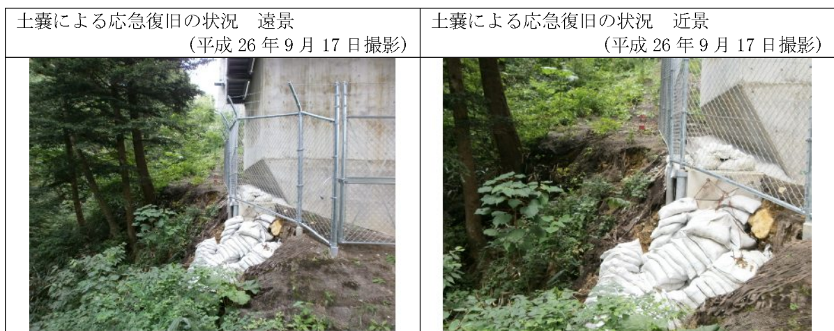
写真 6.1.1-5（1） 右岸橋脚付近の崩壊箇所の応急復旧状況
