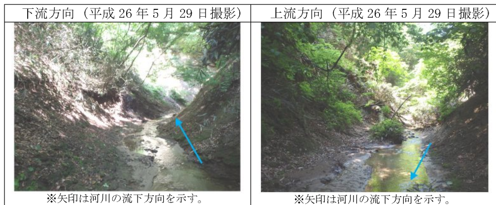
写真 6.1.1-3 工事箇所直下の竜の口溪谷河床部の状況
