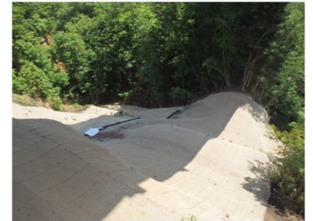
④左岸工事用地下端部 木柵と大型土嚢が撤去され、法面植生工により、溪谷への土砂流出を予防している(前回調査 H25.12.20 から変化)。
