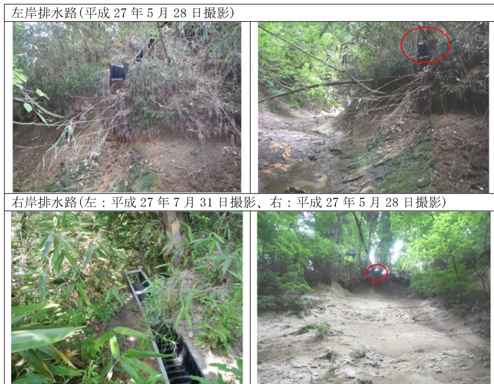
写真 6.1.1-4 斜面排水路の竜の口溪谷への排水状況*
