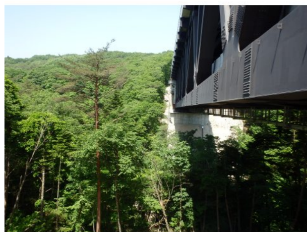
左岸工事箇所全景
