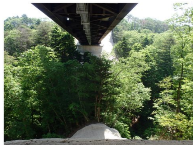
右岸工事箇所全景
