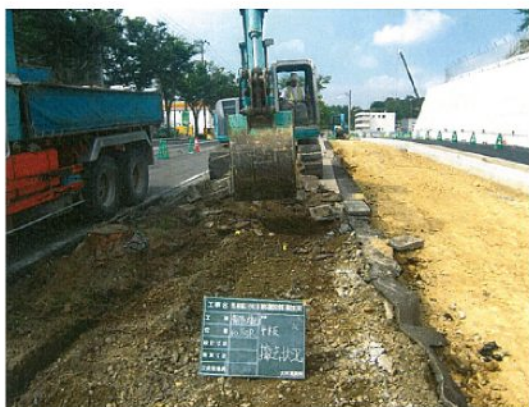
(コンクリート取り壊し状況)
