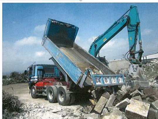
(コンクリートの積み下ろし)
