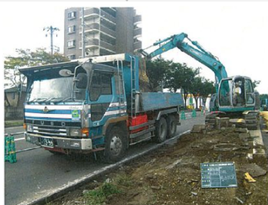
(コンクリート積み込み状況)
