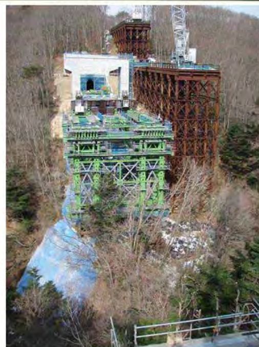
左岸工事箇所全景
