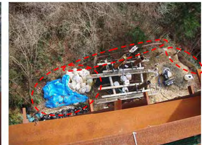
④左岸工事用地下端部 鉄板と木柵、土嚢により、溪谷への土砂流出を予防している
