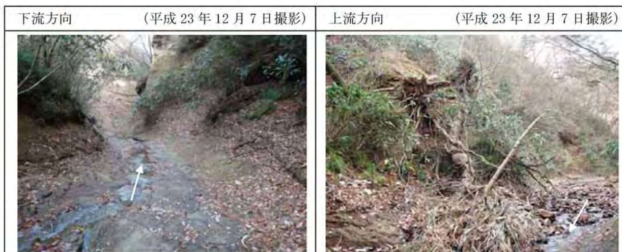
写真 6.1.1-1 工事箇所直下の竜の口溪谷河床部の状況
