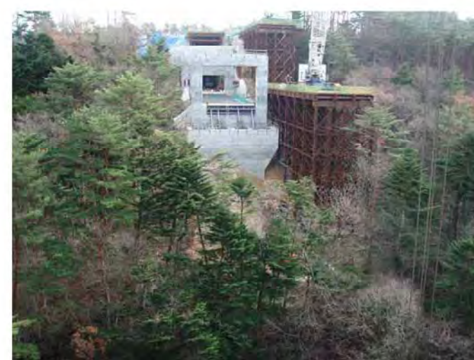
右岸工事箇所全景
