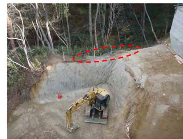
③右岸工事用地上流側面 木柵で工事の影響を最小限に留めている
