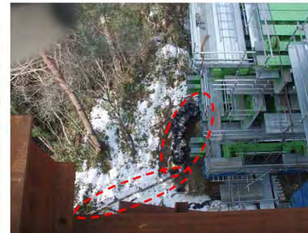
①右岸工事用地下端部 木柵と土嚢により、溪谷への土砂流出を予防している
