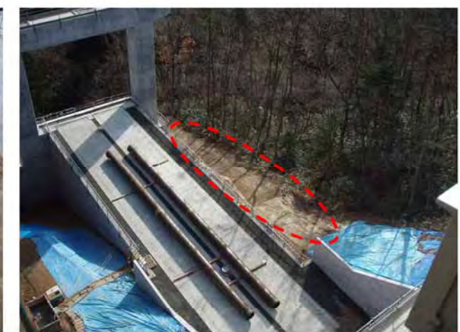
⑥左岸工事用地上流側面 シートとむしろで表層土砂の流出を予防している
