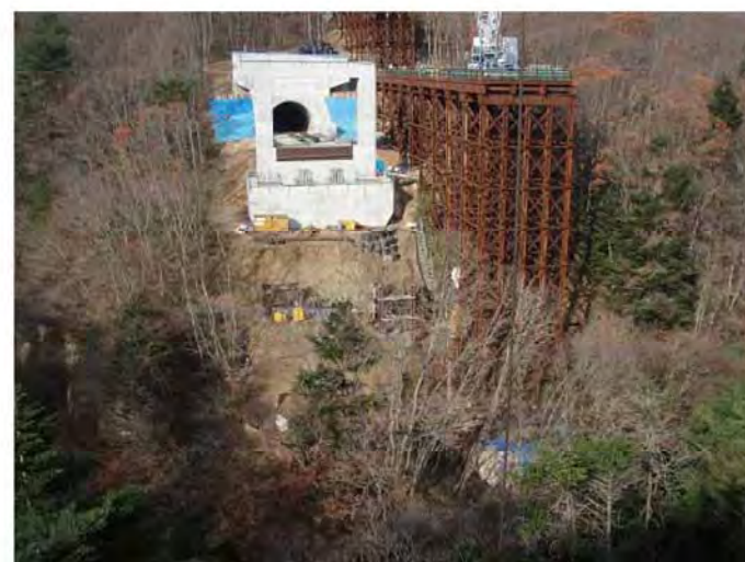
左岸工事箇所全景
