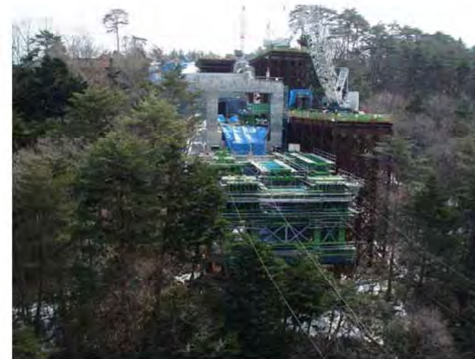
右岸工事箇所全景
