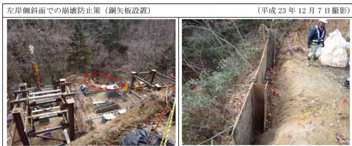
写真 6.1.1-2 左岸工事箇所の斜面崩壊防止策
