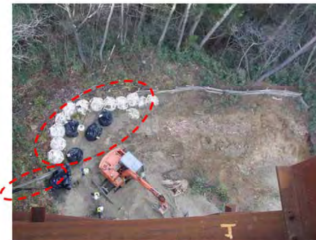
①右岸工事用地下端部 木柵と土嚢により、溪谷への土砂流出を予防している
