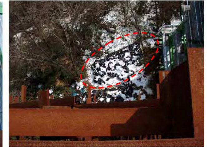
③左岸工事用地下端部下流側 木柵と土嚢により溪谷への土砂流出を予防している
