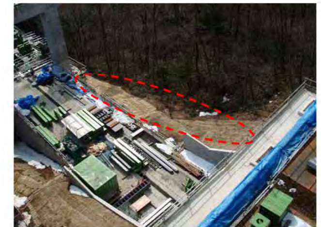
④左岸工事用地上流側面 むしろを敷いて表層の土砂流出を予防している
