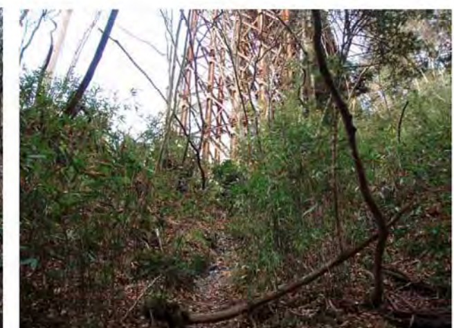
⑤左岸工事用地下端部の下 溪岸の状況 工事用地からの土砂流下や排水流出跡は認められない
