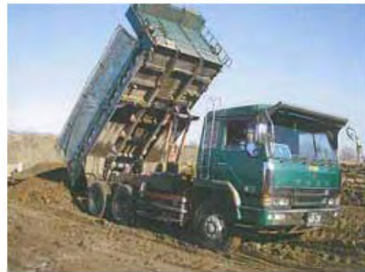
(受入地への残土の積み下ろし)
