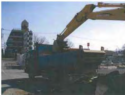
(アスファルト積み込み状況)
