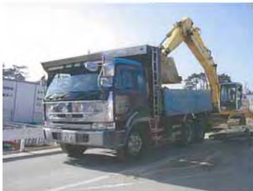
(アスファルト積み込み状況)
