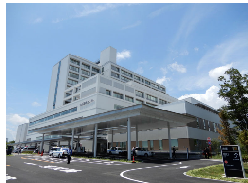
⑥ 病院本館・ロータリー
