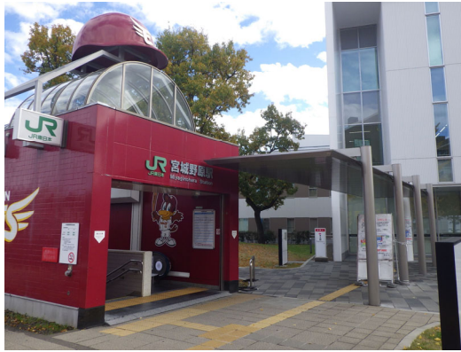
写真 1.4-2 キャノピー設置状況(令和3年11月10日撮影)
