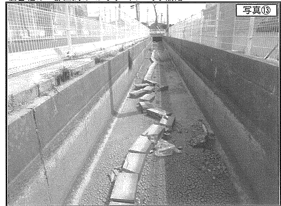
仙台堀の一部区間のコンクリートブロック崩落
