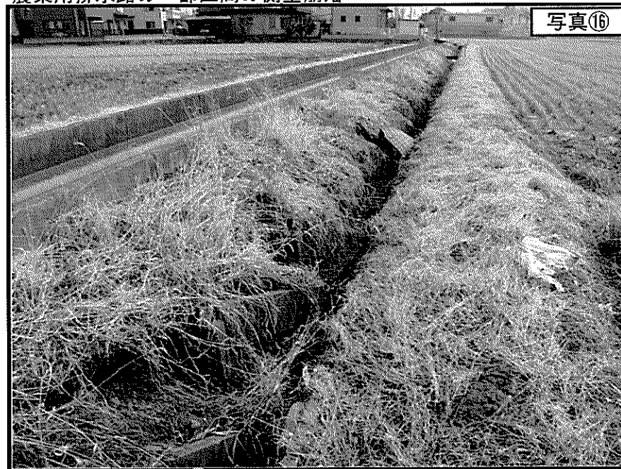
農業用排水路の一部区間の側壁崩落
