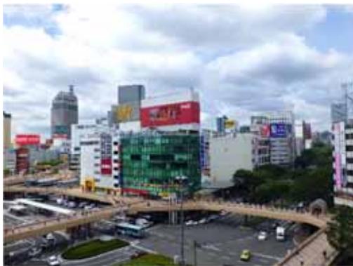
駅屋上からの状況(西口)
