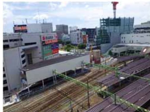
駅屋上からの状況(東口)
