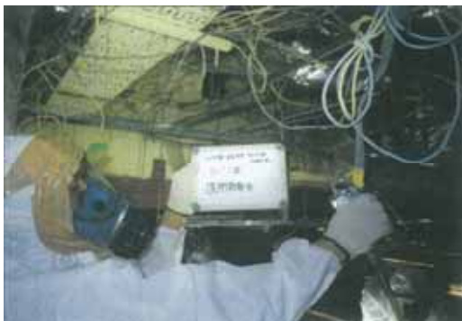
湿潤材散布状況
