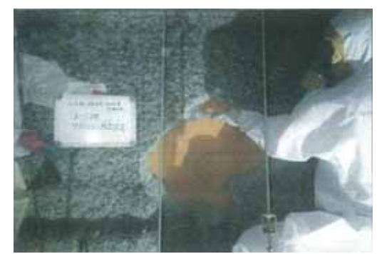
石綿除去作業
