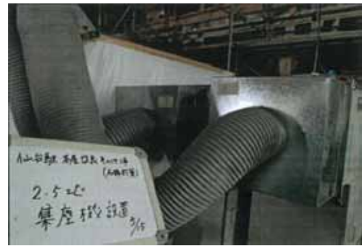
集じん機設置状況
