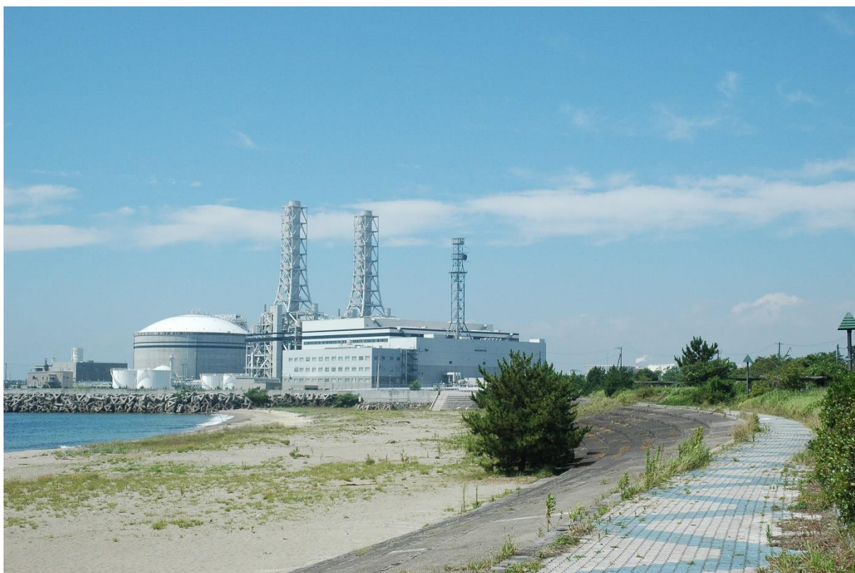
現状 (撮影日 : 令和 3 年 8 月 2 日)
