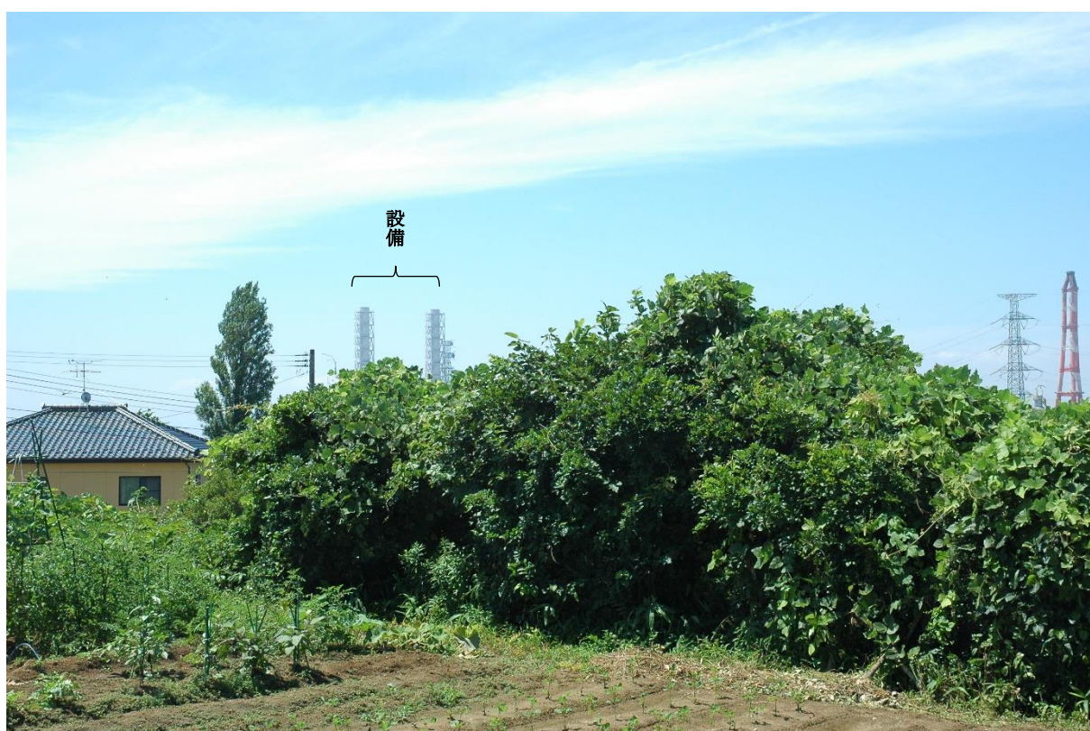
現状 (撮影日 : 令和 3 年 8 月 2 日)
