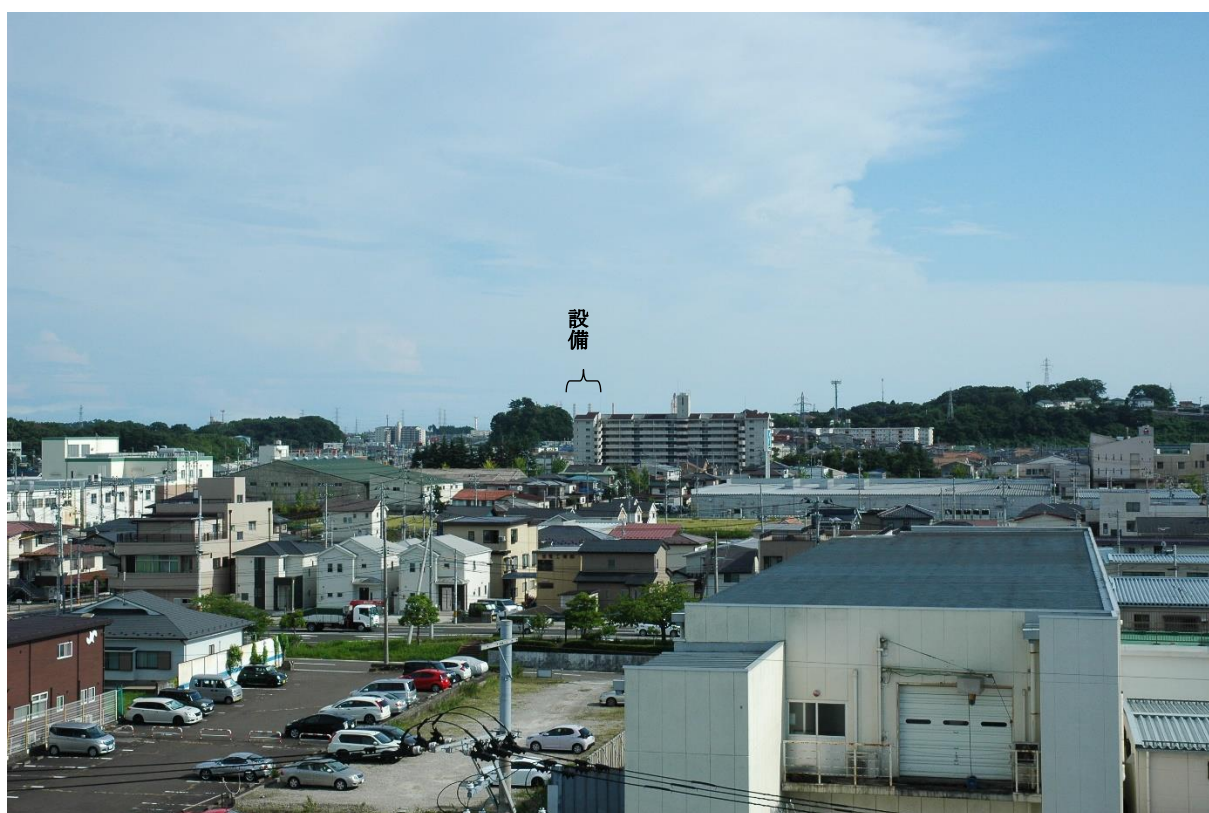
現状 (撮影日: 令和3年8月2日)
