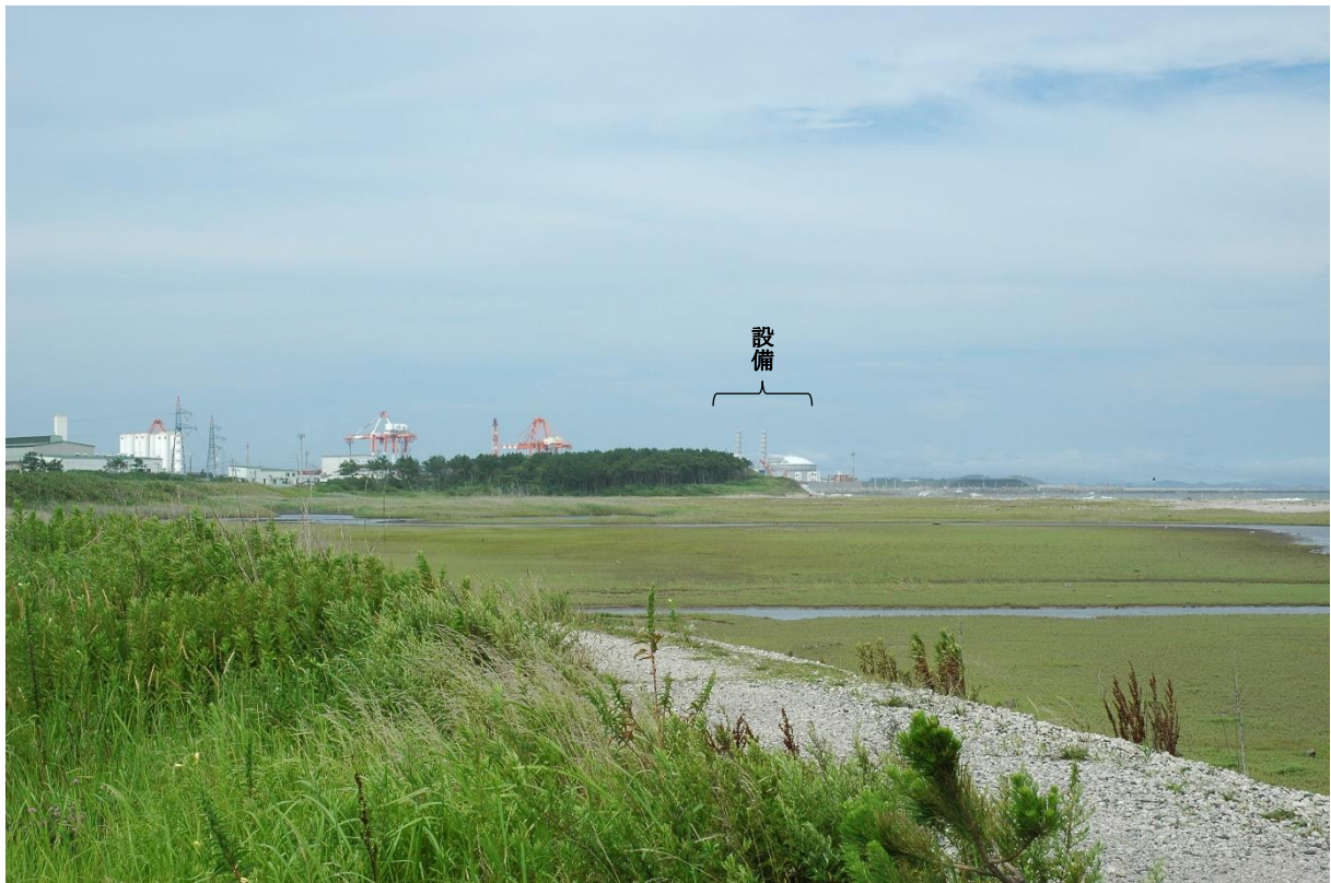
現状 (撮影日 : 令和 3 年 8 月 2 日)
