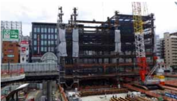
令和4年5月9日 地上階躯体建設
