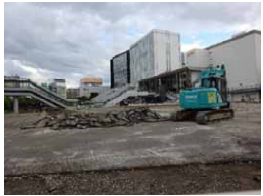
令和3年10月22日 駐車場解体
