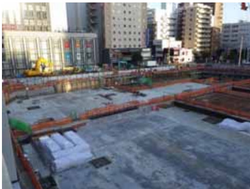
令和4年4月8日 地下階建設
