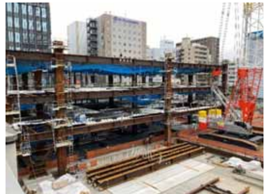
令和4年4月26日 地上階躯体建設
