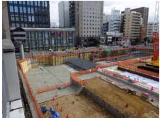
令和4年3月3日 地下階建設
