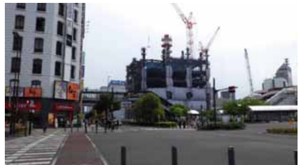
令和4年5月10日 地上階躯体建設
