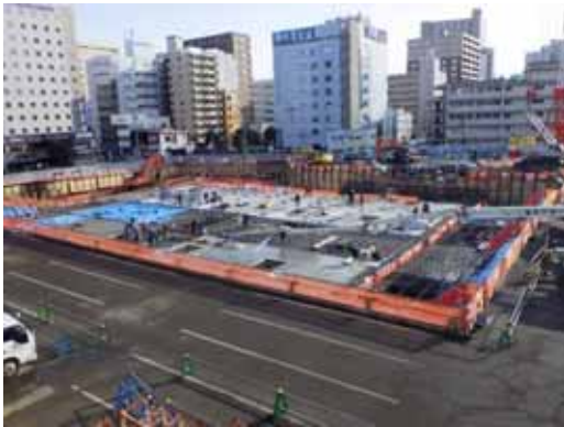
令和4年1月18日 地下階建設
