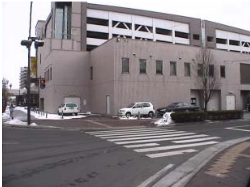
(図表6) 泉中央駅換気機械棟(写真手前の建物)
