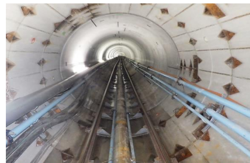
(建設中の広瀬川第3雨水幹線)
