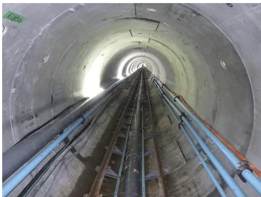
建設中の「広瀬川第3雨水幹線」
