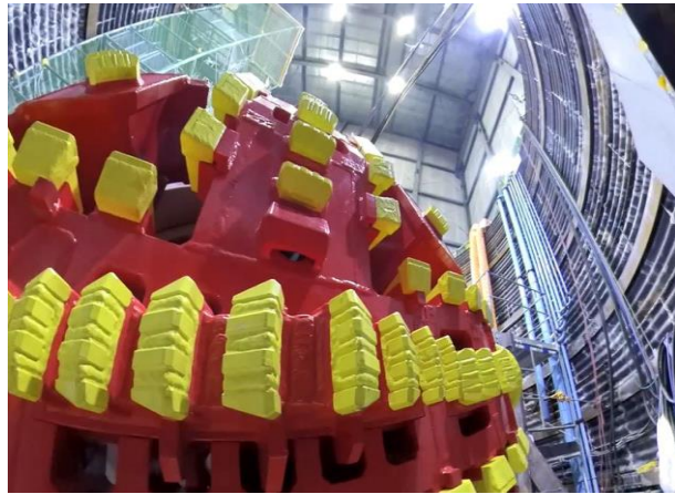
建設中の「広瀬川第3雨水幹線」ミニシールド掘進機 (せんだいTube 動画「大雨による浸水に備えましょう」より)
