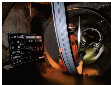
管路の耐震化工事の様子 (更生工法)
