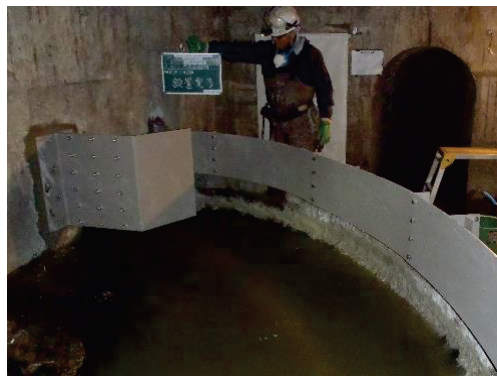
夾雑物除去装置の設置
