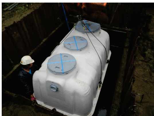
合併処理浄化槽設置工事の様子
