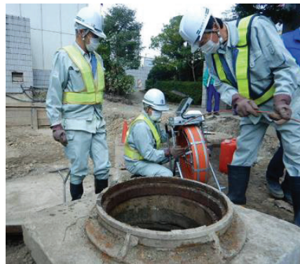
管路施設の点検
