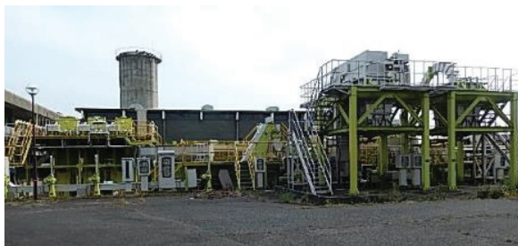
郡山ポンプ場
