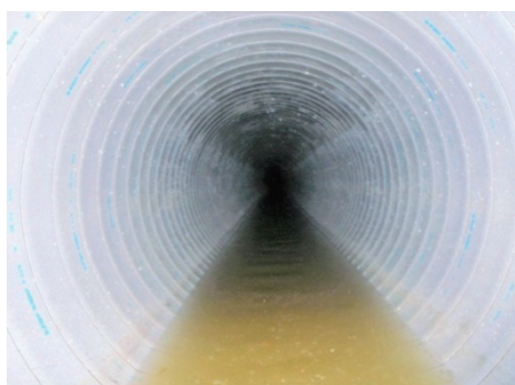
更生工法*による管路の耐震化
