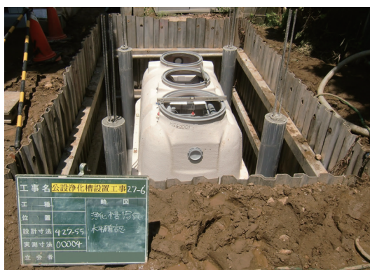
浄化槽設置工事の様子
