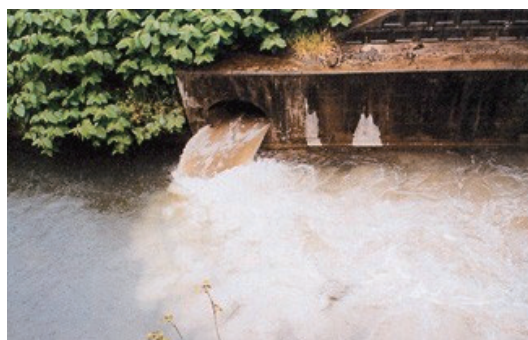
雨水吐き口からの放流状況
