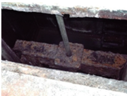
ゲート設備の腐食の状況
