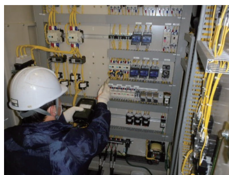
電気設備の点検
