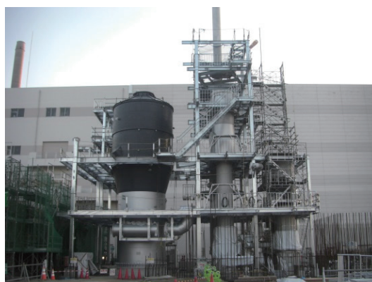
温室効果ガス排出量の少ない 汚泥焼却施設の建設 (南蒲生浄化センター3号汚泥焼却炉)
