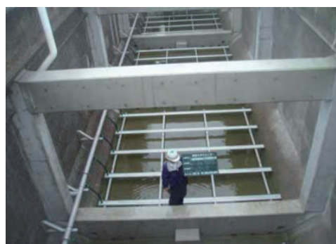
水処理施設の耐震化 (梁・柱の増設)
