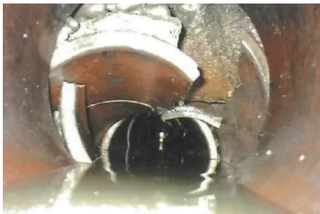
陶管の破損の状況
