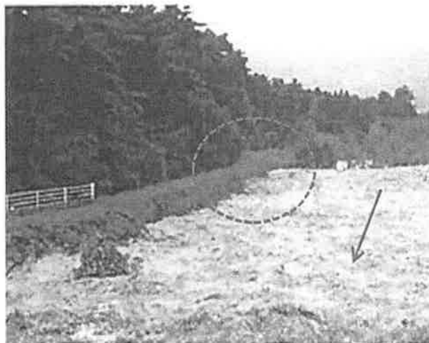
図 - 10 水際線の異常の例
