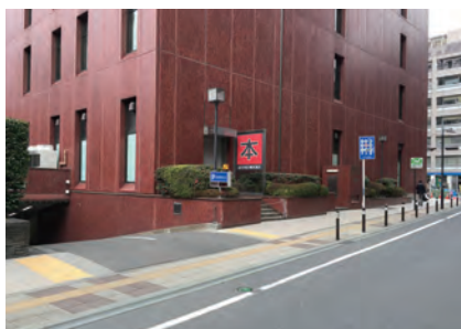
青葉通を避けて設けた駐車場の出入口
