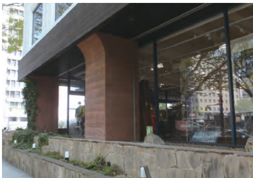
石と木目調の外壁
