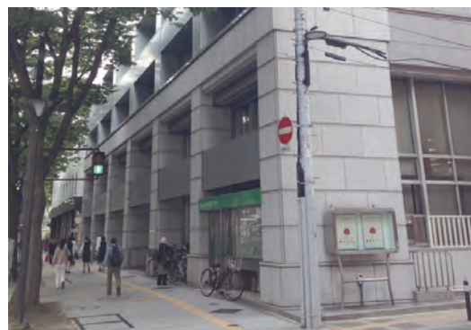
固い表情の石材による外壁
