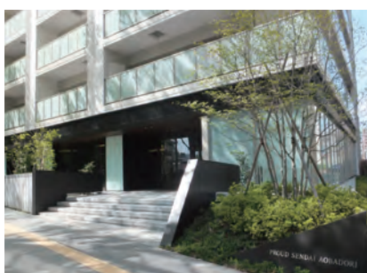
通りに面する部分の緑化
