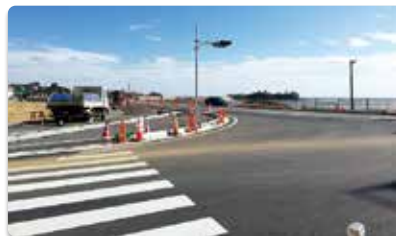
施工写真イメージ
