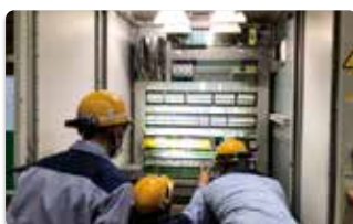
設備点検の様子
