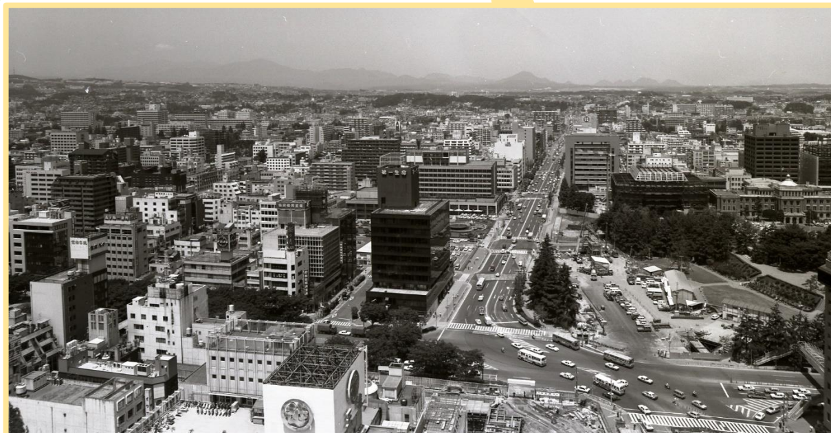
【昭和60 (1985) 年頃の勾当台エリア】 東二番丁通と勾当台通の直線化 (クランク解消) 工事が行われている
