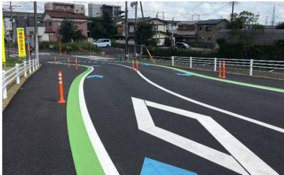
写真③：ポストコーン(オレンジポール)の設置
