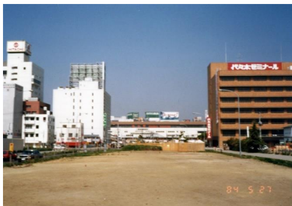
整備中の宮城野通より仙台駅を望む(1984年5月27日 提供/西脇和子さん 所蔵/風の時編集部)
