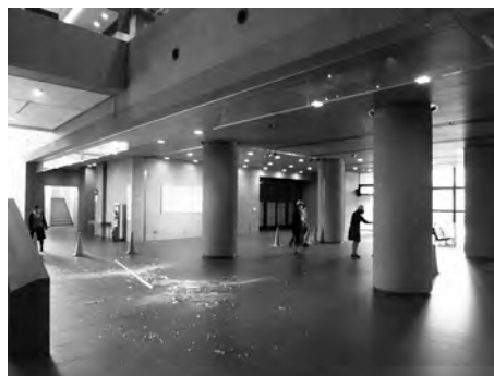
落下した防煙垂れ壁
