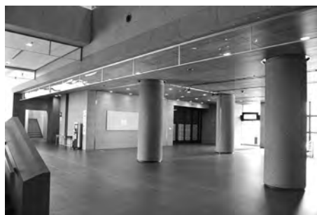
交換工事が終わった防煙垂れ壁
