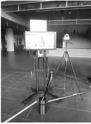
入口に設置したサーマルカメラ
