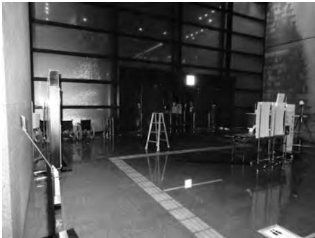
スプリンクラーが破損し、水に浸かったエントランスホール
