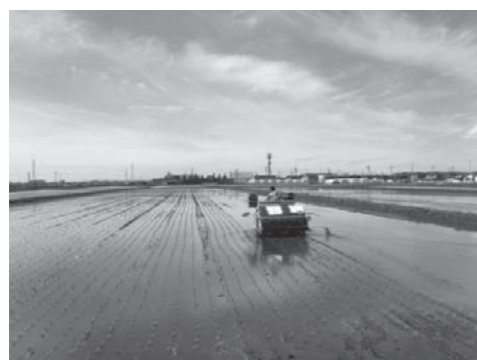
▲大区画化されたほ場
