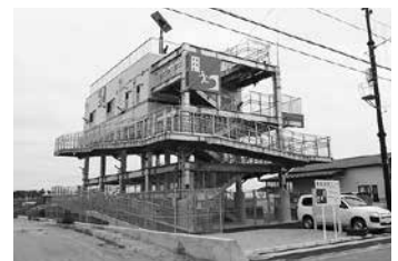
▶避難タワーには、防寒・防風対策として、3階相当の高さに屋内避難スペースが確保されています
