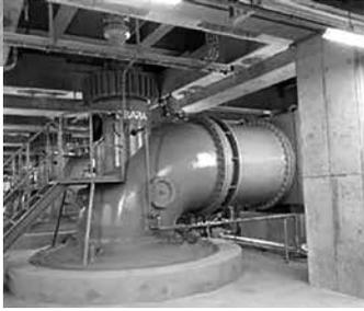
▶鶴巻ポンプ場の雨水ポンプ。地盤の低い地区では、ポンプにより水をくみ上げて川へ排水します
