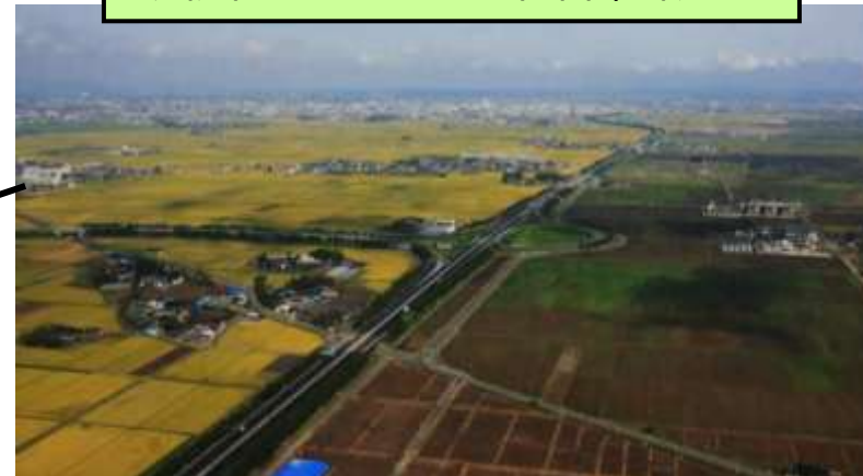
堤防代わりとなった仙台東部道路
