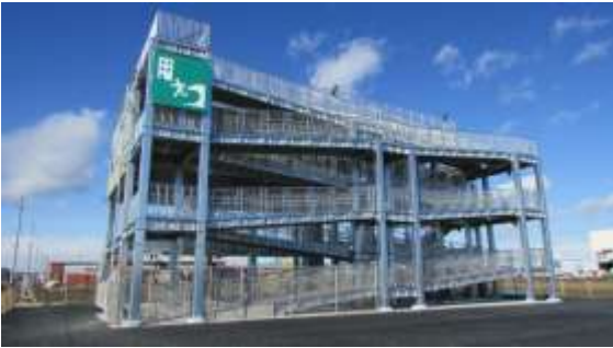
H27.2に竣工した津波避難タワー
