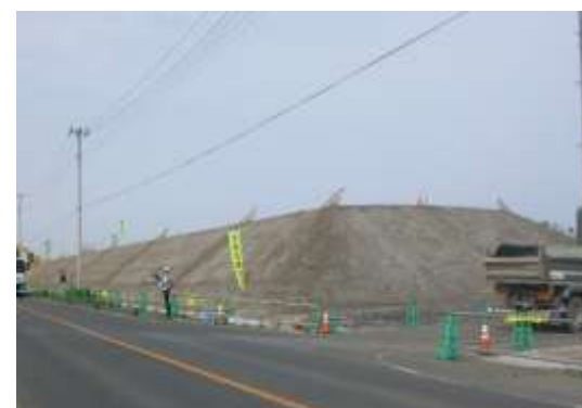
かさ上げ道路の盛土状況(井土工区)
