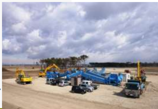
津波堆積土砂の改良状況
