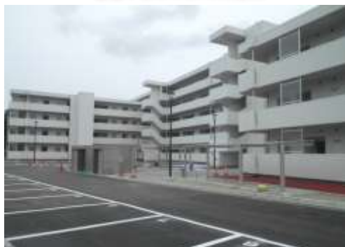
豊屋下第二(H27.9月完成)
