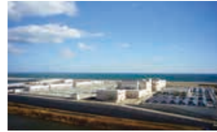
「より良い復興」の考えを取り入れ、耐震性や省エネに配慮した復旧を行った南蒲生浄化センター
