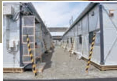
2011年6月までにプレハブ仮設住宅1,505戸が建設された
