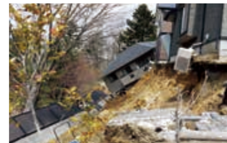
内陸丘陵部の宅地被害
