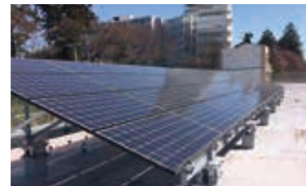
災害時に避難所となる学校などの屋上に設置された太陽光発電パネル
