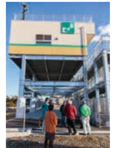
2016年に完成した津波避難タワーは、想定される浸水深から十分な高さとなる6m以上に避難が可能
