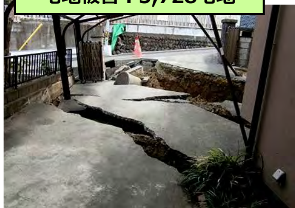
丘陵部の宅地被害(太白区緑ヶ丘地区)
