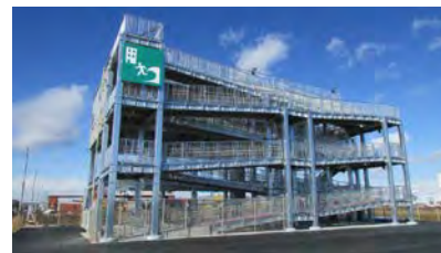
タワー型（鉄骨造） 中野五丁目(平成27年2月完成)
