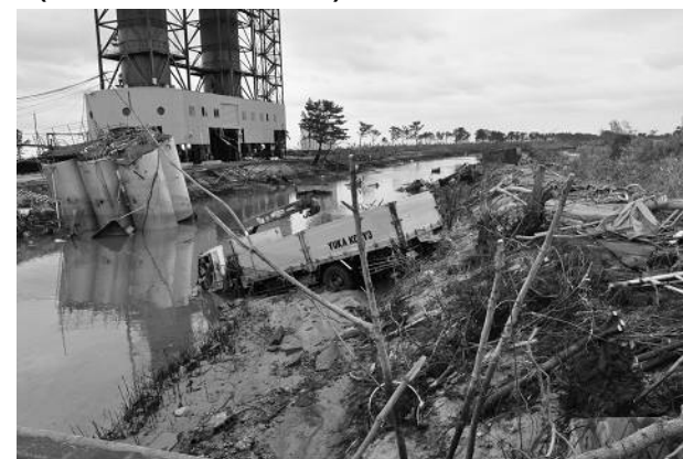
高砂南部排水機場 (宮城野区蒲生)
