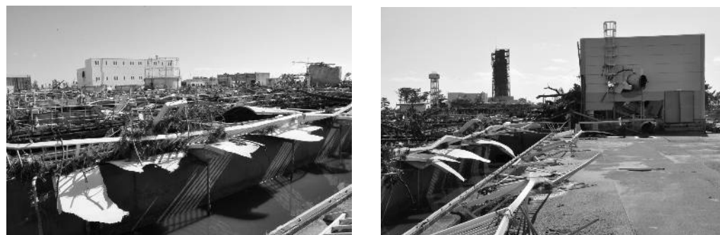
南蒲生浄化センター(下水処理施設)
