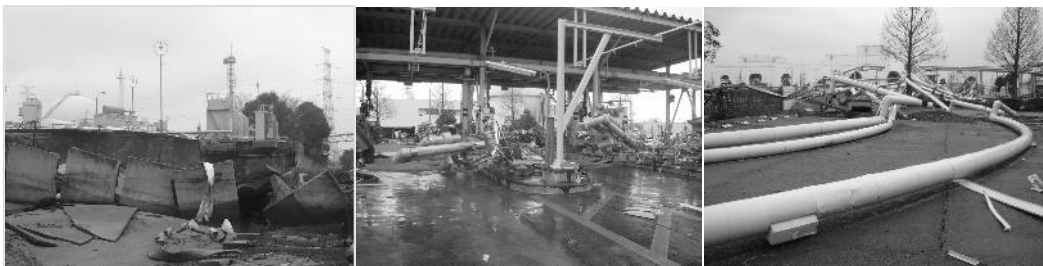
ガス局港工場
