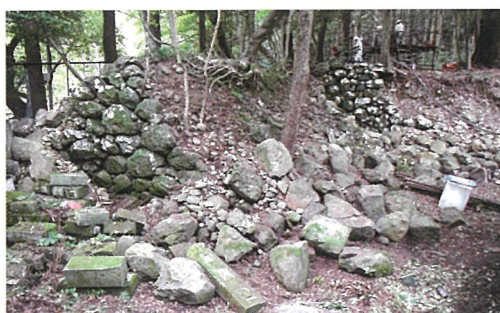
酉門石垣の被災状況
