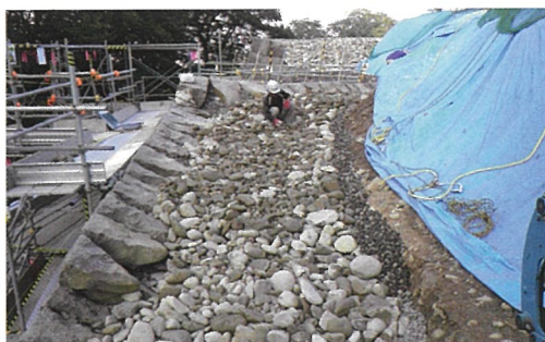
伝統工法による石垣の裏込め
