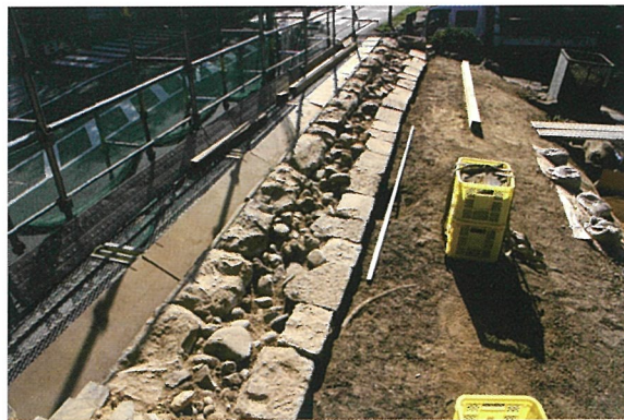
土塀西部の地覆石(東から)
