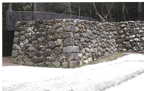
酉門石垣の修復状況
