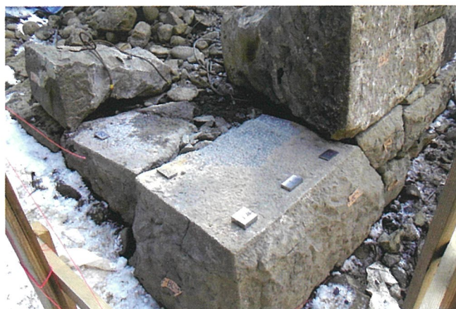
敷金を置いたようす(北西角部) ステンレスの板を置き、上の石を少し持ち上げ勾配を調整しました。
