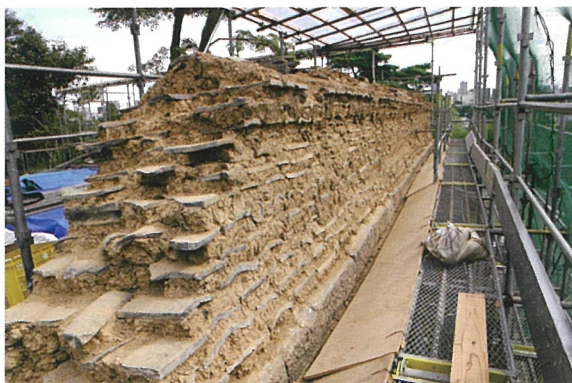
土塀の躯体部(西から)
