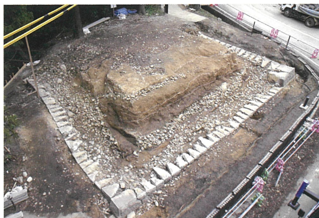
中門北石垣の解体後のようす(北西から) 石垣基部の石材の一部が沈み込み石垣にゆがみが生じていることが分かりました。本来の勾配に戻して積み直すために、一部の石材を交換したり、石の間に敷金(しきがね:金属の板)を挟み込んで調整しました。
