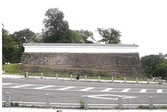
復旧したようす(南から)
