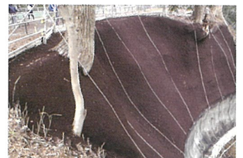
本丸東側崖面復旧工事のようす 崩れた崖面に繊維を混ぜ込んだ土を吹き付けて補強しています。
