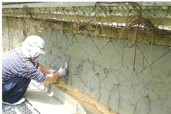
土壁塗り作業
