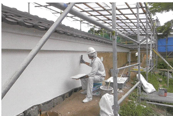
仕上げの漆喰塗り作業
