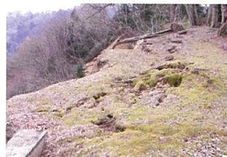
本丸東側崖面に生じた亀裂（北から）
