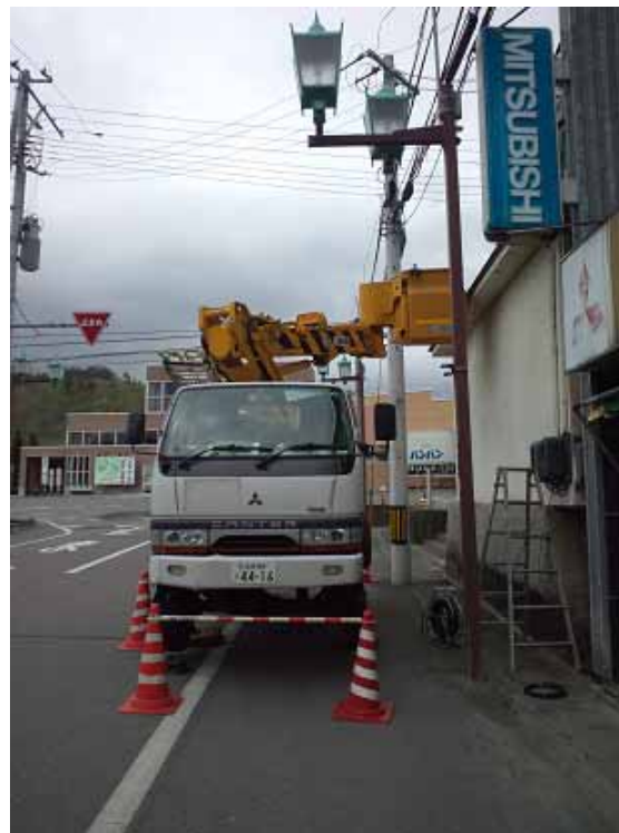
回線工事の様子
