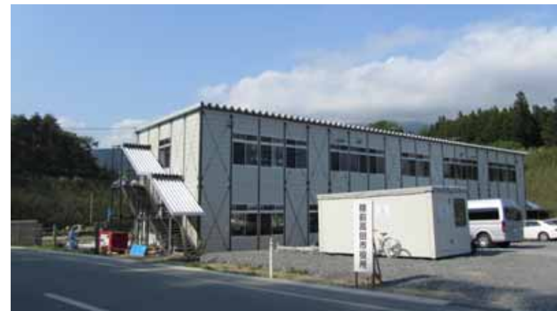
完成後の第1仮庁舎
