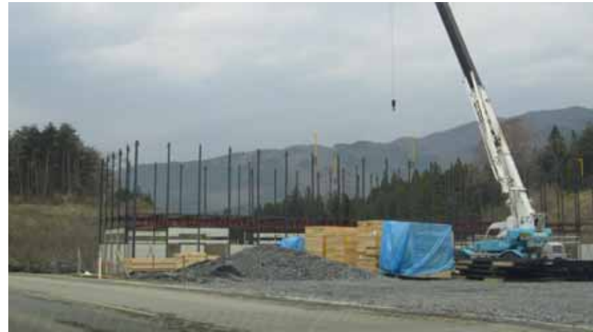
建設中の仮1仮庁舎
