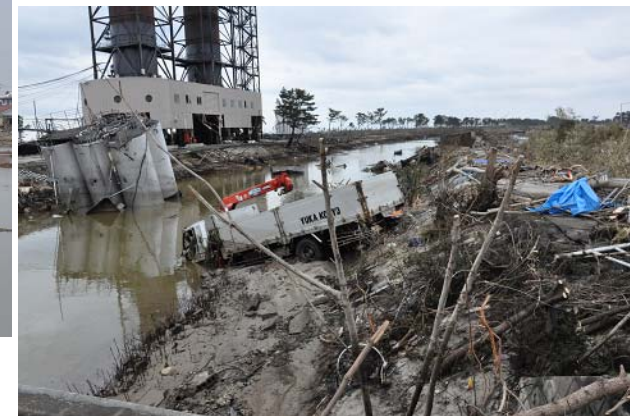
高砂南部排水機場 (宮城野区蒲生)
