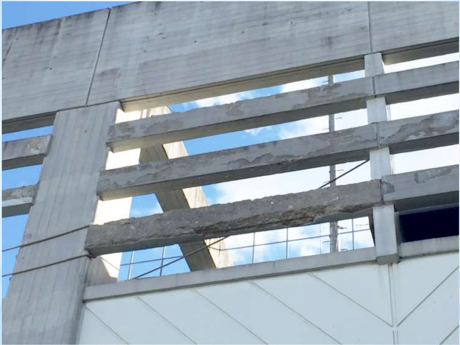
劣化した外壁
