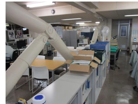
図④ 耐震ブレースによる執務室の分断
