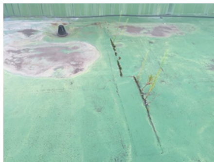
本庁舎屋上防水の状況
