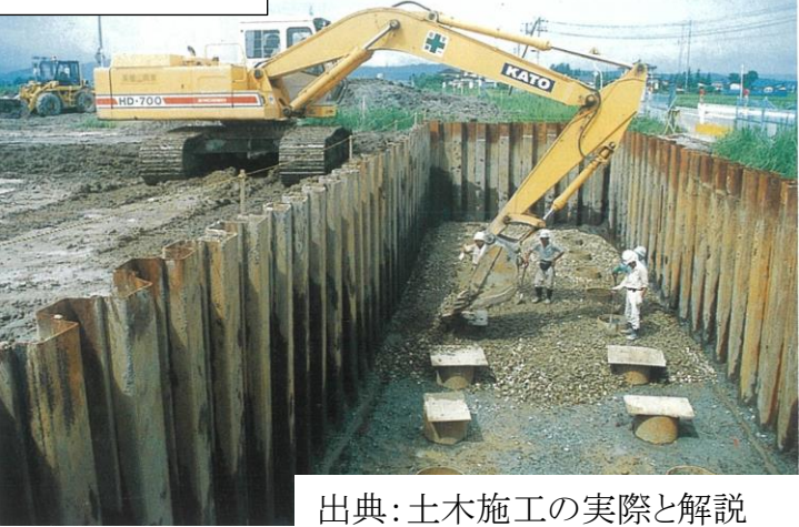
施工イメージ
